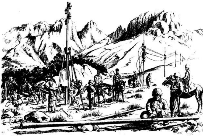
Bauarbeiten im Kaukasus
