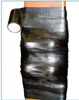
Figure 20 : Isolation avec des couches qui se chevauchent à moitié
