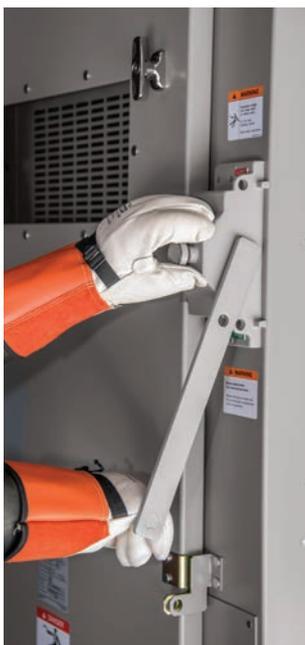
Figure 29 : Fonctionnement de l'interrupteur de charge
