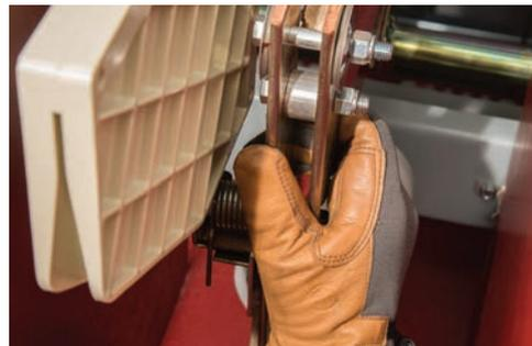
Figure 42 : Dégager les lames de l'interrupteur
